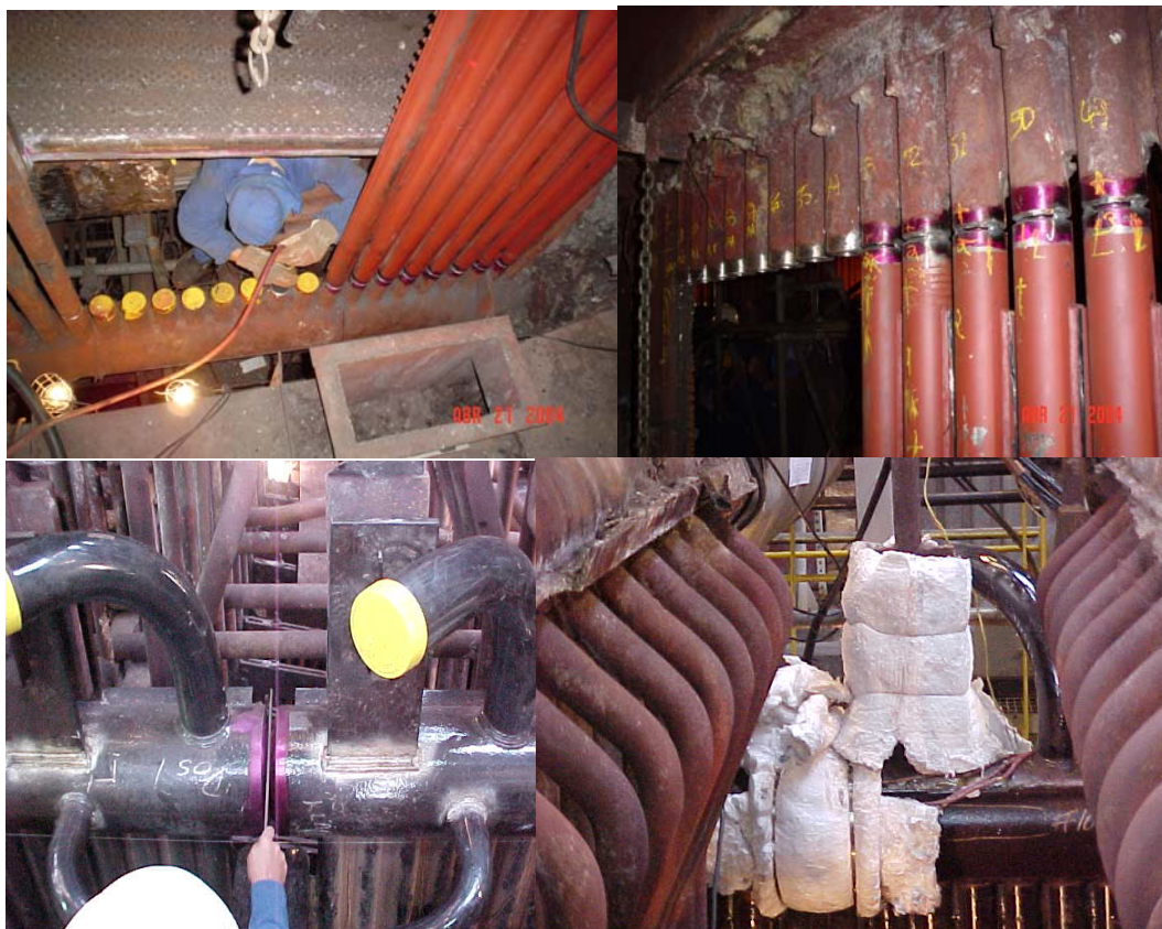
Figura 4 – Soldas e inspeção requer técnicas especiais para prevenção de incidente [5].
